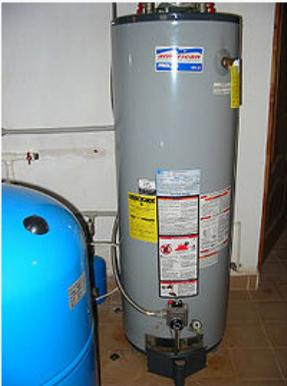
Einfacher, brenngasbetriebener Warmwasserbereiter für Warmwasser um 60 °C.
