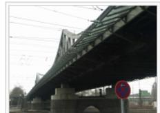
Bild 3: Brückenaufleger u. orthotrope Fahrbahnplatte
